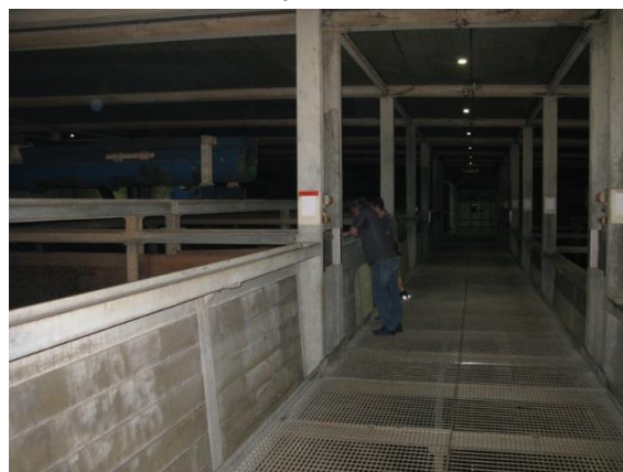
Obr. 22: Hala s aeróbnymi, intenzívne prevzdušňovanými boxami, kde prebieha kompostovanie počas 5 týždňov.
