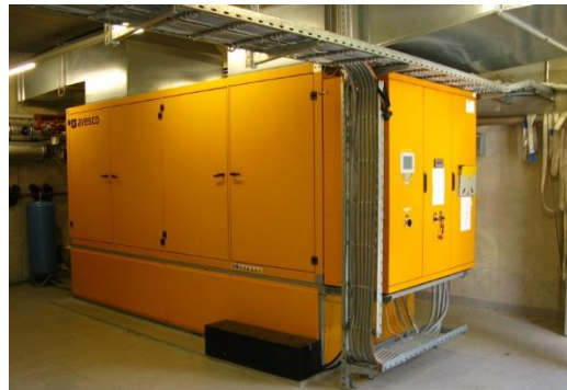
Obr. 25: Kogeneračná jednotka.
