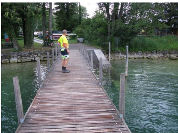
Obr. 35: Mestská lodenica na jazere Zugersee s rampou a navijakom na vjazd a vyťahovanie lodí z vody.
